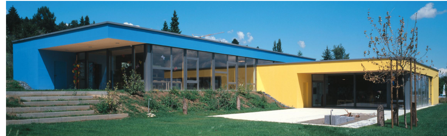
Neubau eines Doppelkindergartens in Lohn-Ammannsegg.
