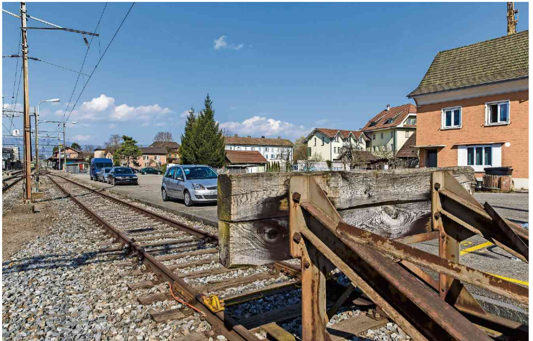
Das Bahnhofsgebiet ist heute planerisch Niemandsland. Es soll nun prioritär entwickelt werden.
