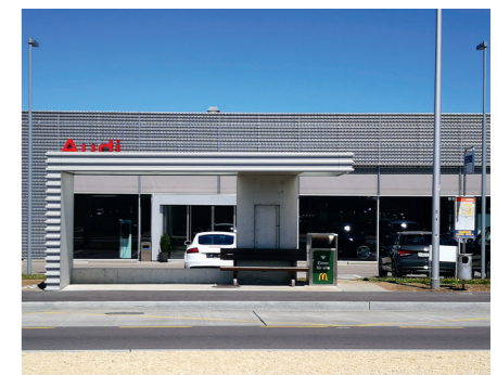
Neubau Bushaltestelle in Zuchwil
