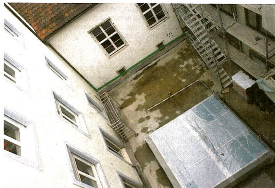
Blick in den Innenhof und auf den Lichtschacht in die Kundenhalle.
